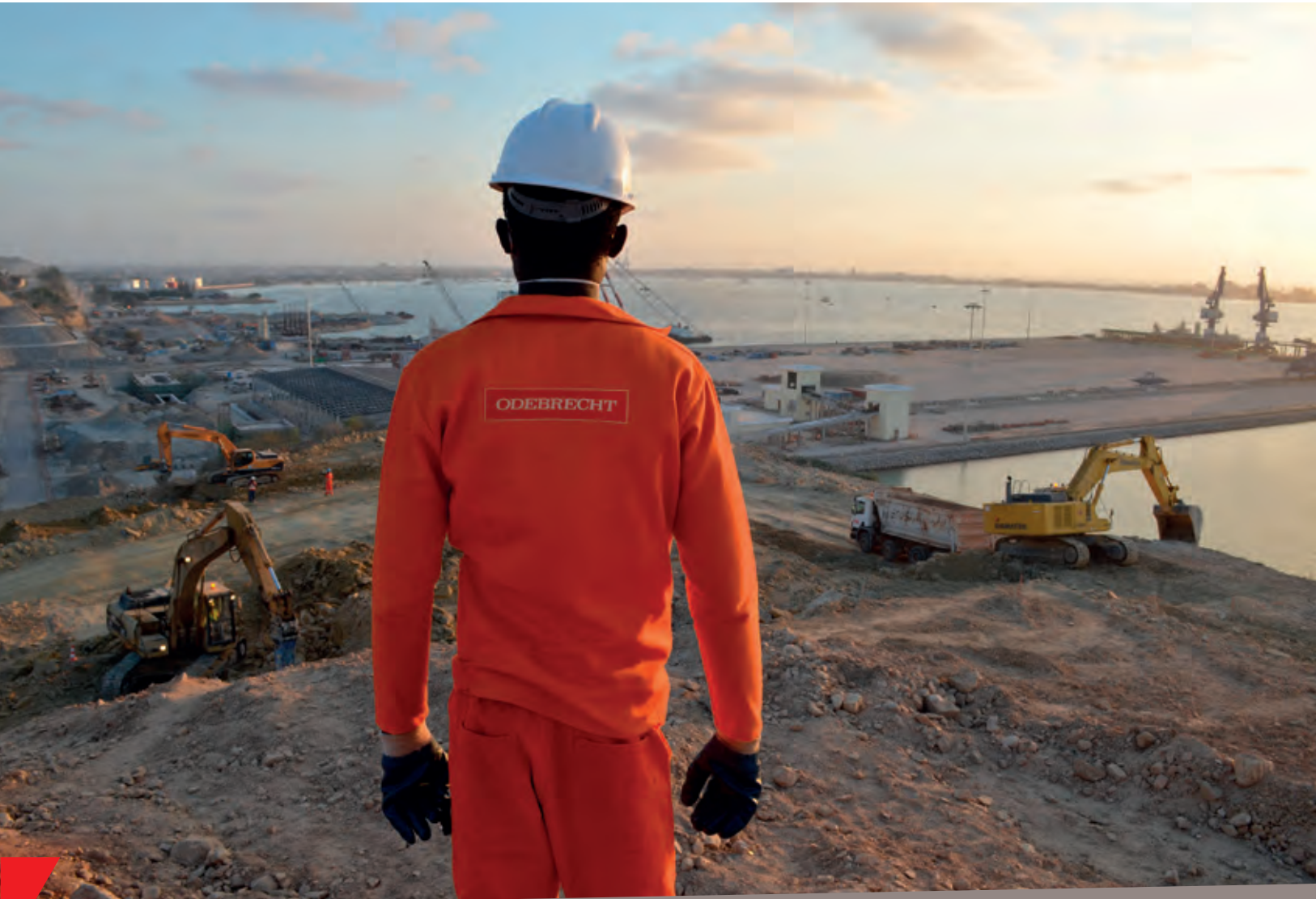
Obras da Refinaria do Lobito, em Angola
